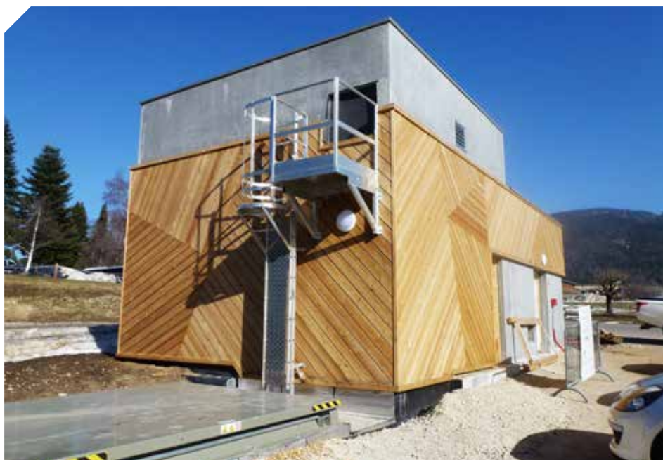
Dernière réalisation - chaufferie d'Autrans 2
