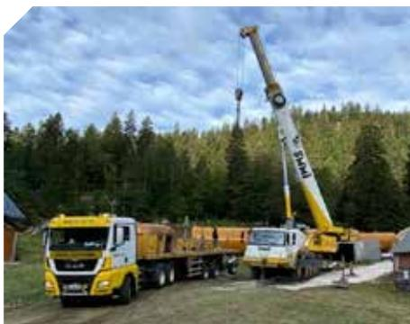
Nous avons profité des travaux de montée de l'eau potable et de l'assainissement à La Sure pour installer dans les tranchées un troisième tuyau, tout à fait indépendant, qui récupèrera les eaux de sources pour créer au bas des pistes « **une carrière à neige** » permettant de produire de la neige pour le domaine débutant dès les premiers froids.
